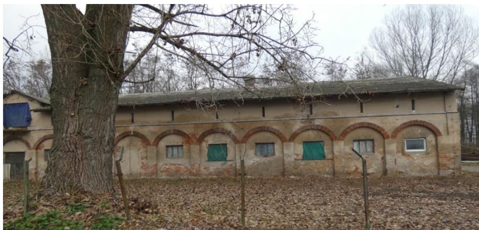
Fotografia 19. Pozostałości zespołu dworsko-parkowego, owczarnia – widok od strony południowej
