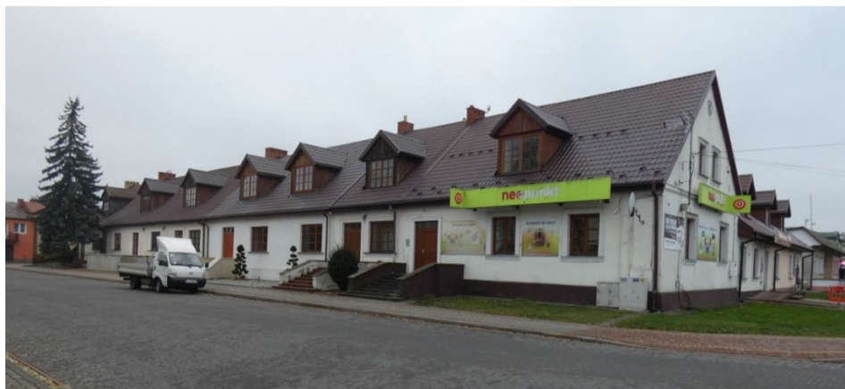
Fotografia 21. Zajazd (austeria) – widok od strony północno-wschodniej
