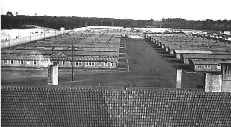
Fot. 1. Widok z dachu komendatury na KL Ravensbrück.
