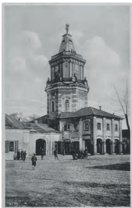
Fot. 4. Siedlce. Stary Ratusz (widok w stronę zachodnią z ul. Warszawskiej). Wyd. fot. B. Sadowski, Siedlce [ok. 1926 r., nr negat. 9293]. Sygn. 33
